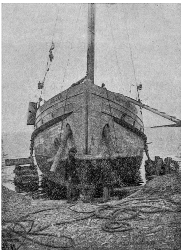
Носовая часть шхуны «Полярная Звезда», приподнятая домкратами. Фот. Ю.Д. Чирихина.
